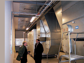
Die Einkaufszentren Nova Lund 1, 2 und 3 in Lund Schweden haben insgesamt 20 Stück VPM 3200 Geräte je mit 32.000 M 3 /h, die alle Luft-Nach-Bedarf Betrieb fahren. Das heisst die einzelnen Läden können selbst die Temperatur bestimmen obwohl die Lüftung und Kühlung zentral ist. Unter anderem diese Lösung hat dazu beigetragen, dass Nova Lund Einkaufszentrum des Jahres in Schweden genannt wurde. Andere grosse Einkaufszentren wie Hyllinge in Schweden und RødovreCentret in Dänemark haben auch Nilan Gewählt.
