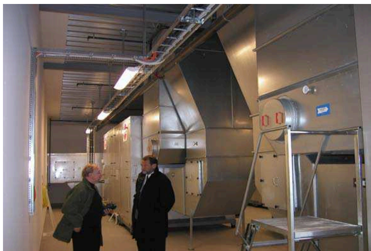
Lüftungszentrale – 15 x 32'000m 3 /h – Nilan VPM 3200
